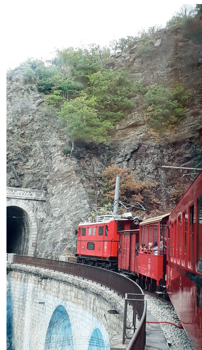
Photo 6 : le petit train de la Mure sur un viaduc et entrant dans un tunnel
