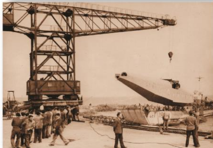
Au-dessus : Construction d'un élément central de voilure à la SNCASO de Saint-Nazaire et déchargement d'une coque arrivant du Havre. (Collection Eco musée de Saint-Nazaire)
