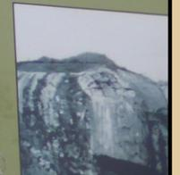
**Bâtiment semi-enterré avec camouflage type « roches ». La construction de chaque casemate a nécessité 1 080 m<sup>3</sup> de béton et 64 tonnes d'acier.**
