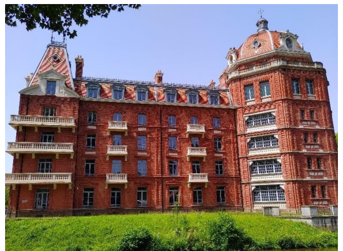
Nouvelle aile plus récente occupée par les Cadres
