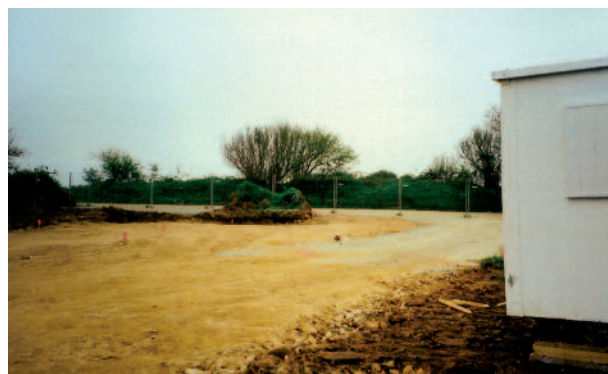
Le terrain est prêt pour la construction (novembre 1996)
