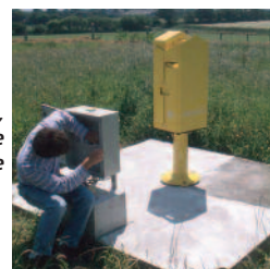
Installation par le TI, Pourchasse du télémètre
