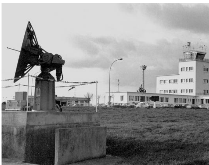
Bloc technique vue façade Est, au premier plan le RAFIX
