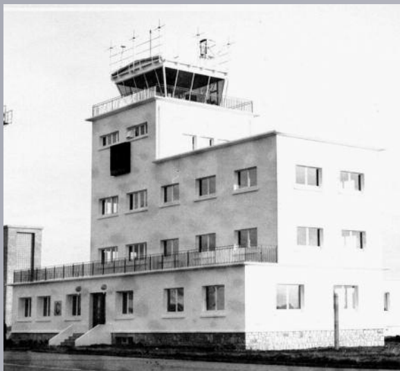
Bloc technique façade ouest
