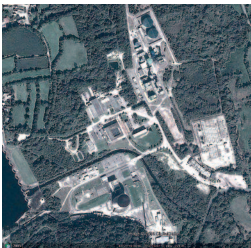
◀ Vue aérienne de la centrale Brennilis
