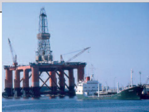
plateforme de forage
