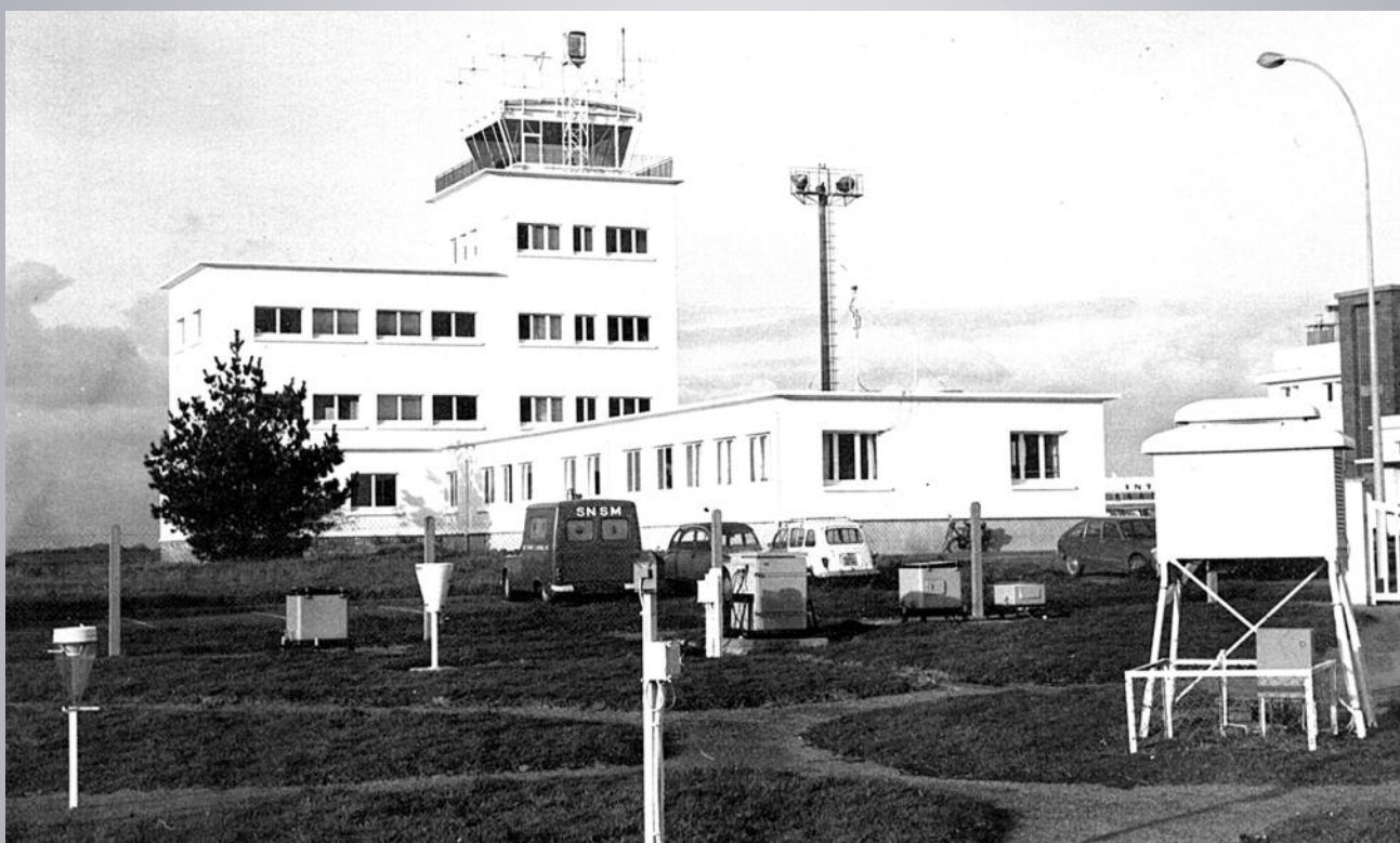
Bloc technique façade sud, au premier plan le parc instruments météo
