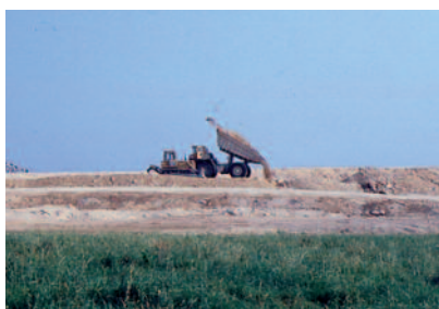
Travaux piste côté Est
