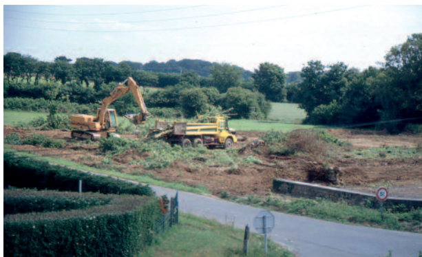
Les travaux de terrassement débutent (mars 1996)
