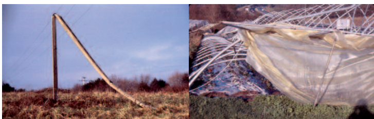
Quelques uns des dégâts provoqués par l'ouragan (nuit du 15 au 16 octobre 1987).
