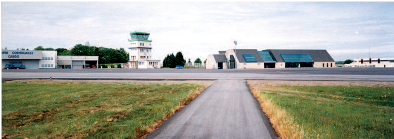
Vue générale, la station est située dans la tour de contrôle (au rez de chaussée)
