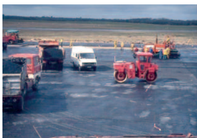
Enrobage du parking avion
