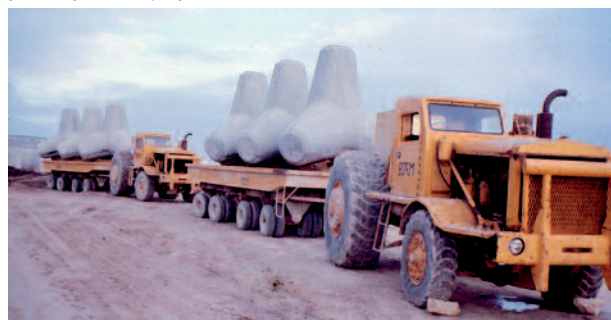
Transport des tripodes brise-vagues du musoir de jetée
