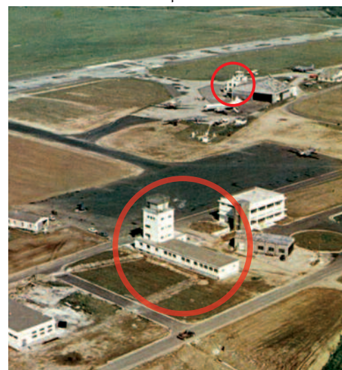
Au premier plan le nouveau bloc technique, en arrière plan l'ancien.
