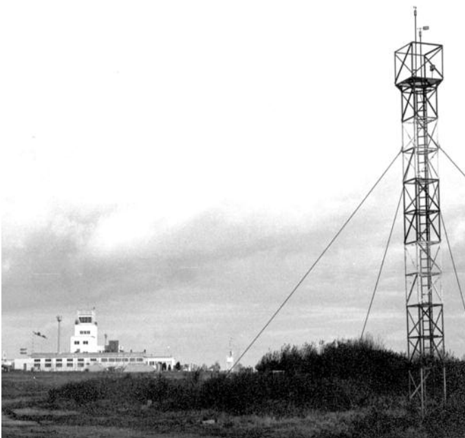
Vue générale , au premier plan le pylône anémométrique
