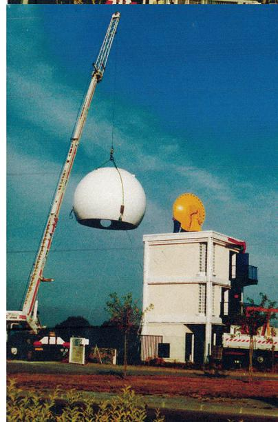
Photo 8 : pose du radome sur l'antenne
