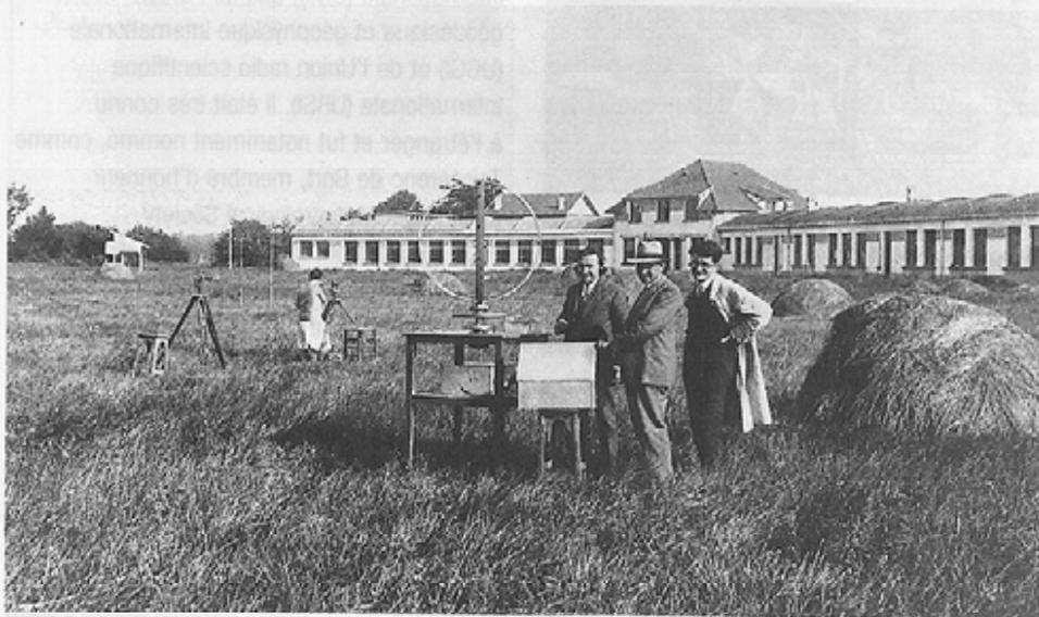
Premiers essais de radiogoniométrie vers 1932. Bureau est au centre entre Gret et Perlat devant l'appareil de sa fabrication. On distingue sur la gauche un théodolite sur son pied : il servait à contrôler les données du goniomètre. Photo Météo-France.
