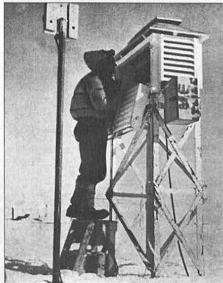
Observations météorologiques en surface aux heures synoptiques. Sur le côté de l'abri, un poste téléphonique permet la transmission immédiate des observations.
