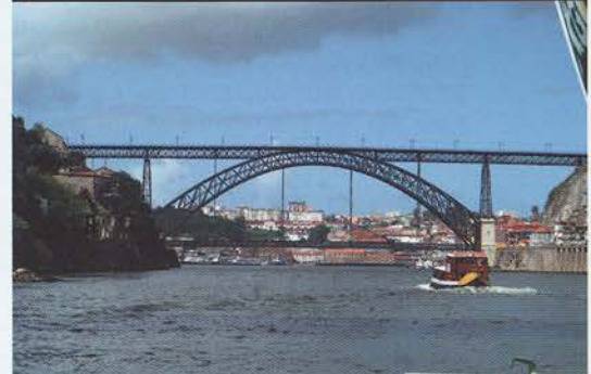
2 Embouchure du Douro à Porto, pont construit par G.Eiffel
