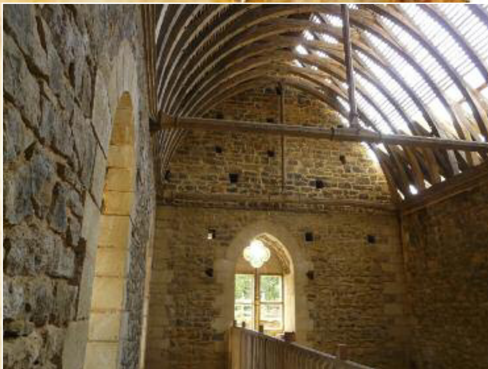
7 Charpente du logis seigneurial.
