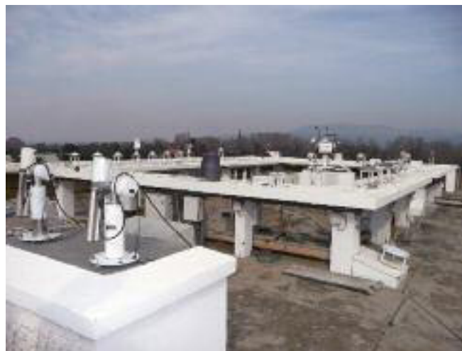
Vue de la terrasse du Centre avec des instruments en cours d'étalonnage.
