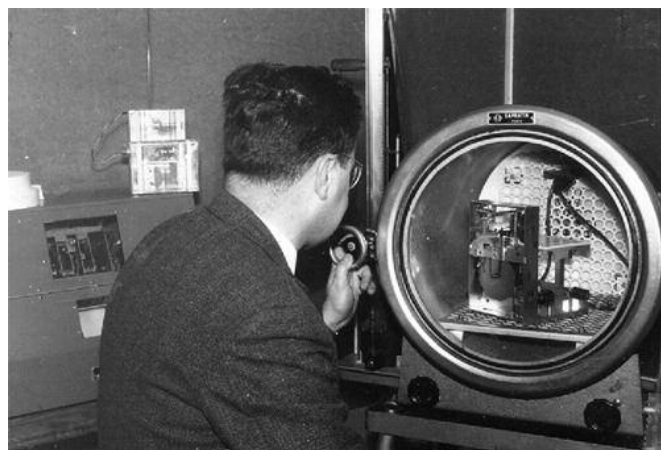
2/étalonnage par Jacques d'une radiosonde (capteurs de pression et d'humidité) au moyen du caisson à vide
