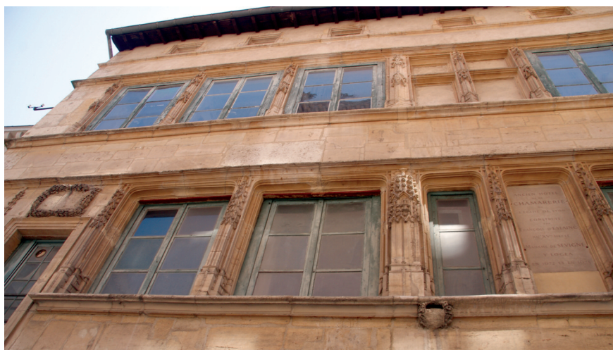
Photo 13. Fenêtres à meneaux.
