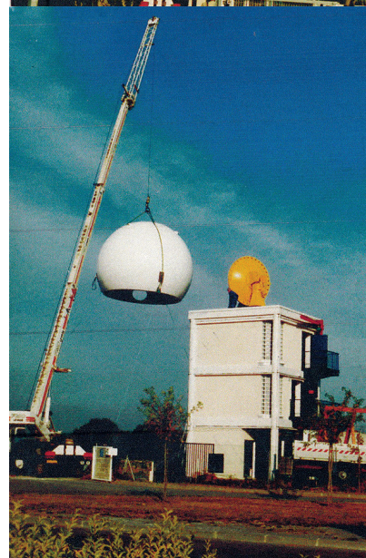
Photo 8 : pose du radome sur l'antenne
