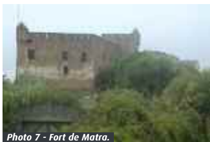
Photo 7 - Fort de Matra.
