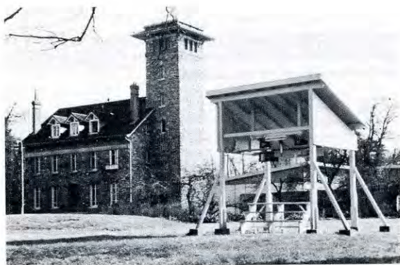
Institut de Physique du Globe au Parc St Maur, L'abri météorologique type I.P.G.
