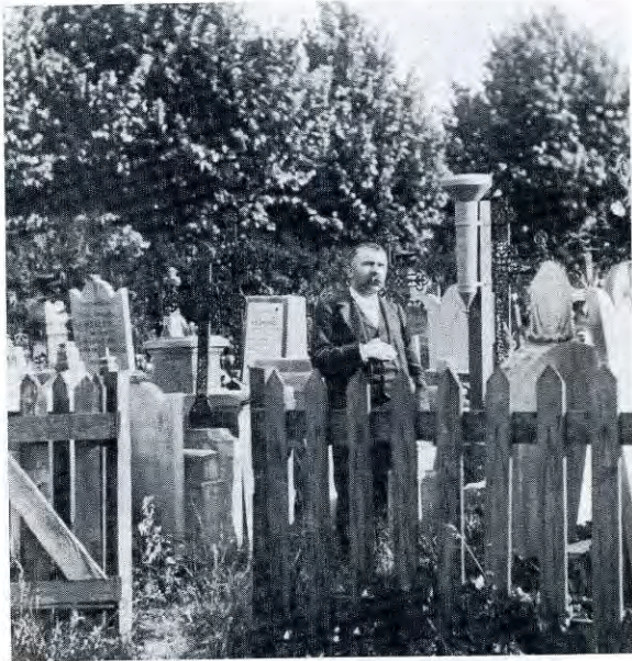
Poste pluviométrique établi au dépôt des objets funéraires au cimetière de Pantin (1899)
