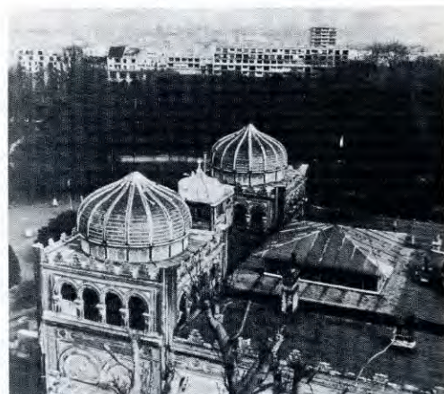
Les coupoles vues du sommet de la tour anémométrique
